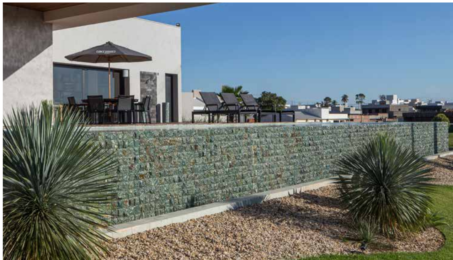
Andrade Oliveira Arquitetura - Foto: Jefferson Ohara - TS-061
